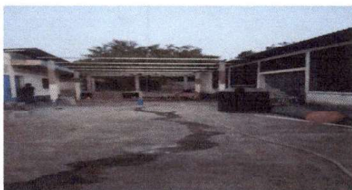
Foto 3: sustitución de lamina por lamina troquelada calibre 26, sustitución de soporte de madera por metal
