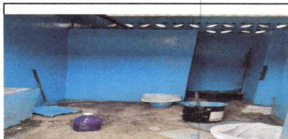
Foto 6: sustitución de sanitarios
